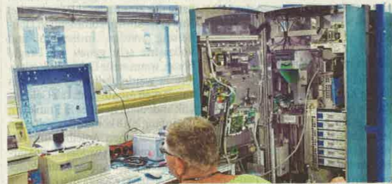
Innenleben mit viel Technik: Mitarbeiter Peter Dorgmann überprüft die Funktionen eines Fahrscheinautomaten.
